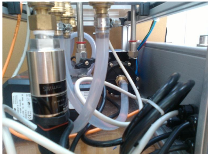
Abbildung 17 Schlauch zum Anschluss des Kühlers
